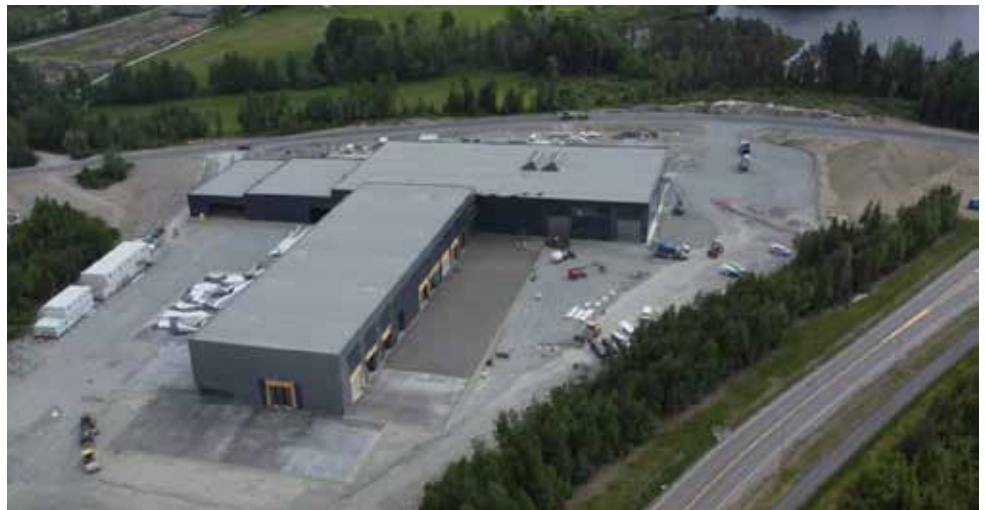
Bygget er i rute, og skal stå klar til overlevering i oktober 2024
