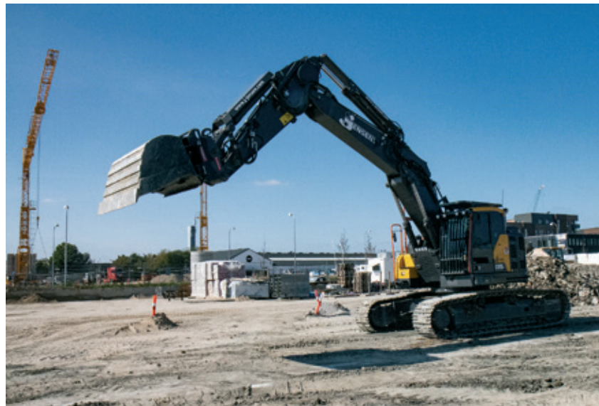
Opgaven i Brøndby er foregået i 3 etaper, og nu mangler kun den sidste: at grave betonfundamentet med ilagte jernbaneskinner op. Lige et job for en Volvo ECR235EL..
