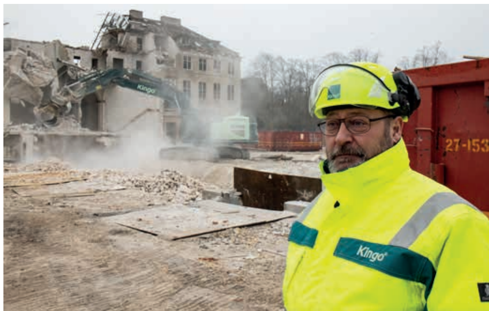
På pladsen ved Rigshospitalet i København har entreprenør Jesper Frost Jespersen overblikket i nedrivningen. Han forventer, at alt er ryddet midt i marts måned.
