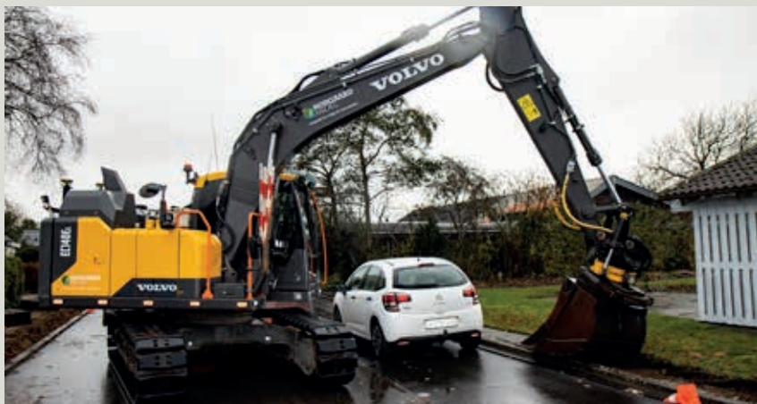
En parkeret bil er ingen forhindring. Martin Andersen arbejder knivskarpt og styrer den fleksible maskinarm og skovl perfekt i en kontinuerlig rytme.
