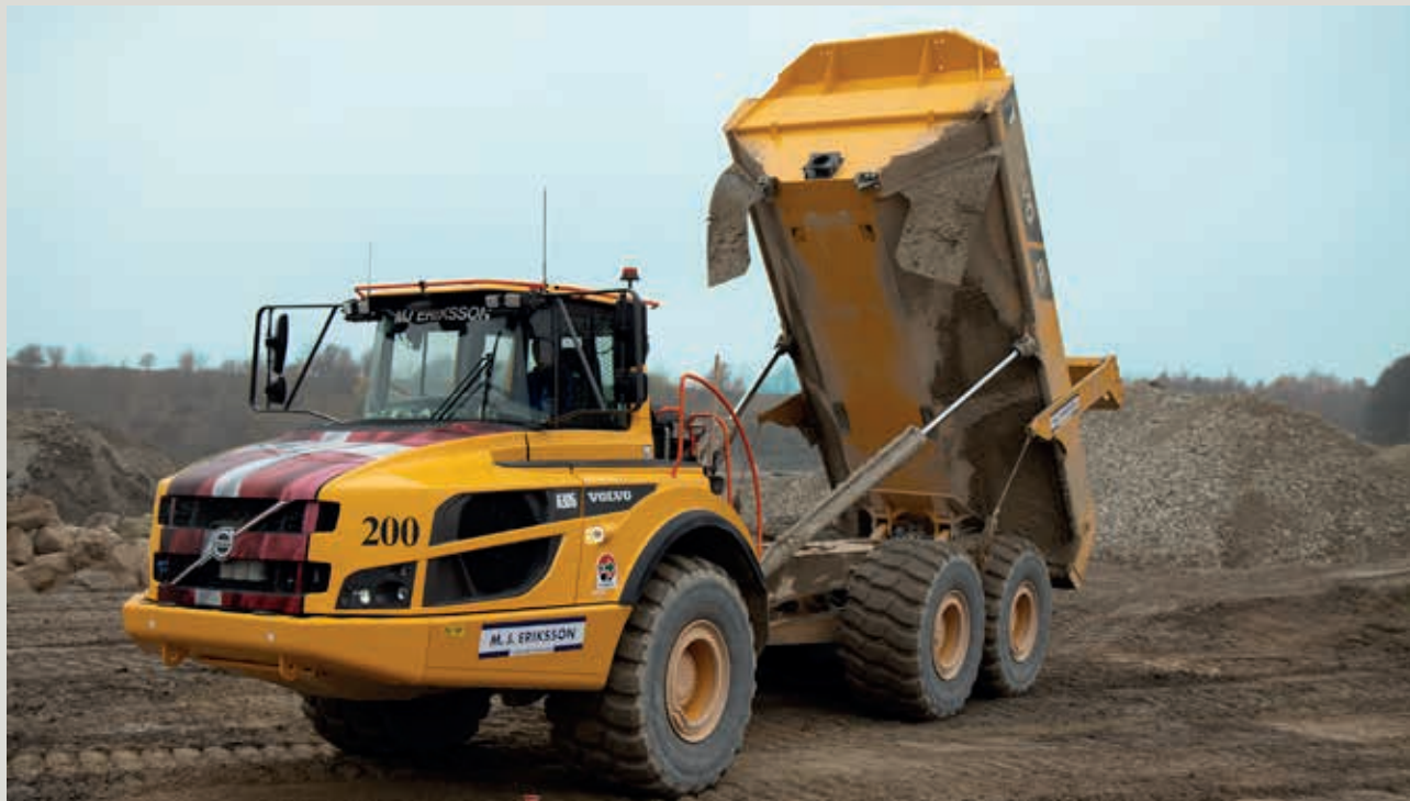
Hos DSV i Hedehusene flytter MJ Eriksson jord og materialer for byggeriet af to nye lagerhaller. 10 gule Volvo-dumpere deltager i arbejdet.
