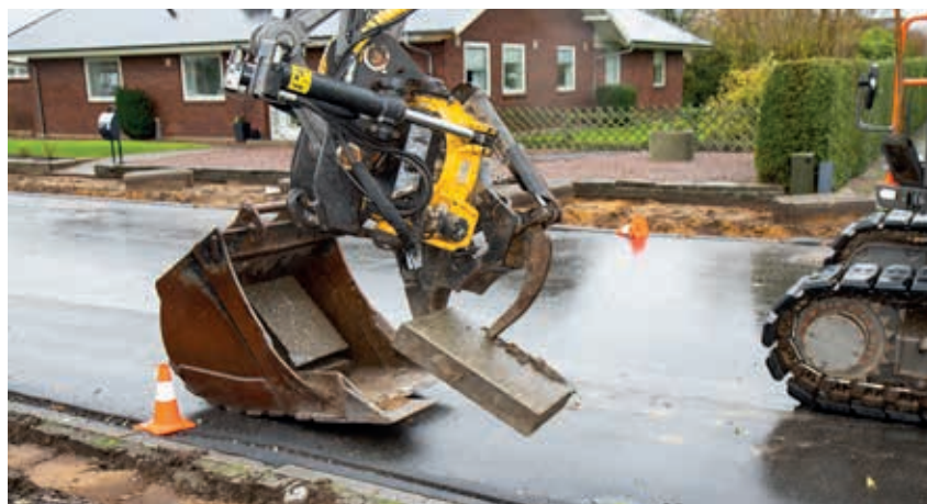
Som en smidig pilfinger griber masterkloen om genstridige fliser, der pænt sættes af i skovlen.
