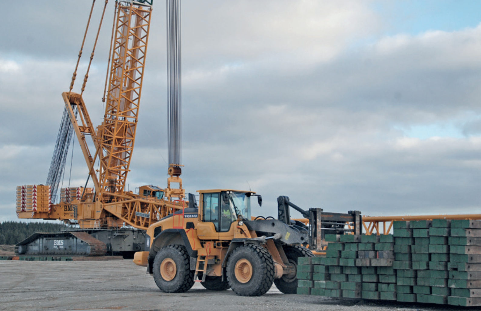
Stakken af madrasser til kranen er stor.
