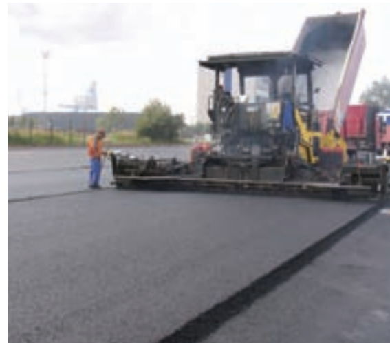
用于大宽度摊铺作业的机械拼装式熨平板
