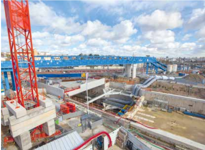
01 Gualtiero Zamuner från Société du Grand Paris i dialog med Nicolas Chartier-Kastler och Maxime Lecot från Bouygues vid byggarbetsplatsen i Clamart. 02 Clamart är en av de mest komplexa byggarbetsplatserna i Grand Paris-projektet.
