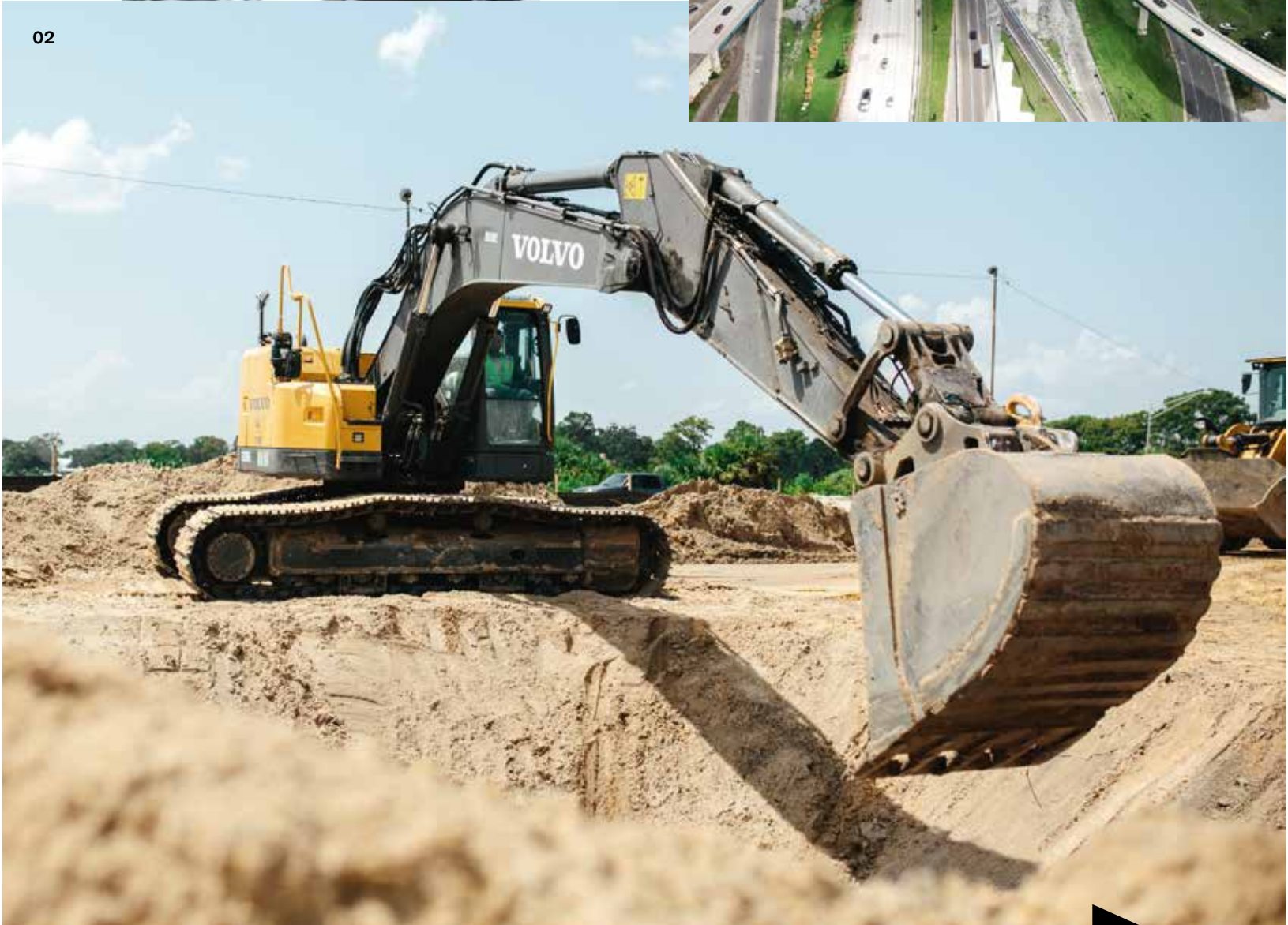
01 Varje dag sker över 1,5 miljoner biltransporter på Interstate 4 i Florida. 02 Vanliga uppgifter för Volvos grävmaskiner är att gräva diken och fylla lastbilar.
