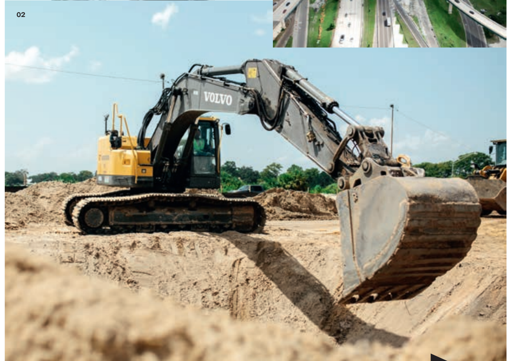
01 Każdego dnia kierowcy i pasażerowie odbywają ponad 1,5 miliona podróży autostradą międzystanową nr 4 na Florydzie. 02 Do typowych prac wykonywanych koparkami Volvo należą wykopy oraz załadunek samochodów ciężarowych.
