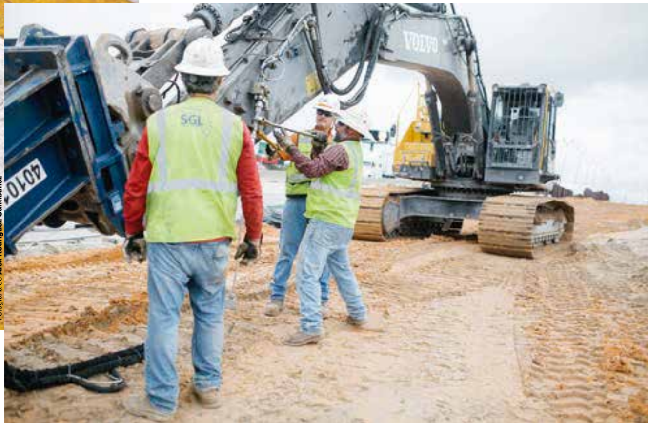
Las labores de construcción de la I-4 se llevan a cabo en un entorno urbano, a veces junto al tráfico.
