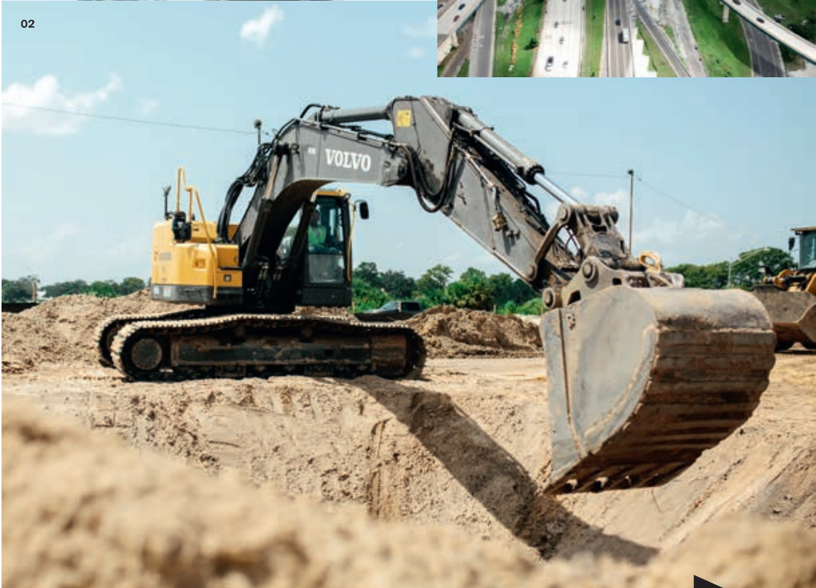
01 Mehr als 1,5 Millionen Verkehrsteilnehmer befahren Floridas Interstate 4 jeden Tag. 02 Typische Aufgaben der Volvo-Bagger sind das Ausheben von Gräben und das Beladen von LKW.
