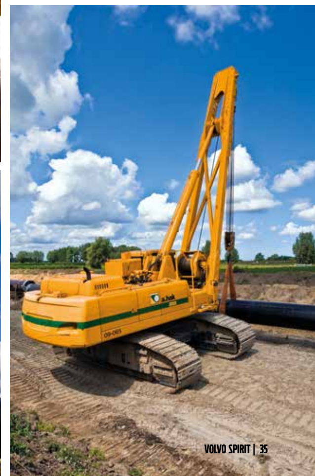
Esta foto e abaixo: assentador de tubos PL4608 da Volvo na obra
