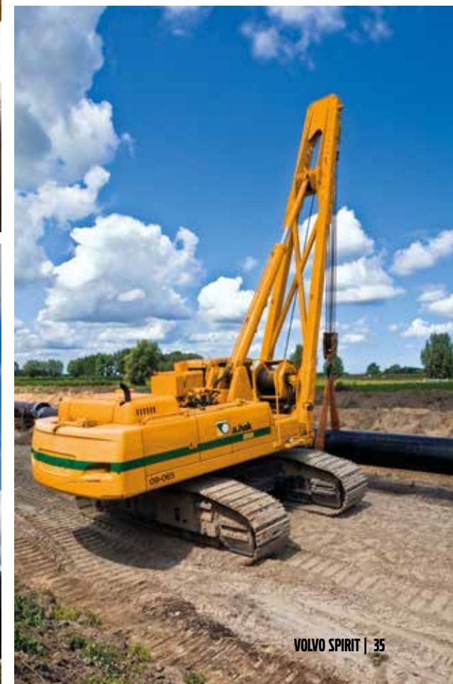
Deze foto en onder: Volvo PL4608 pijplegger op locatie
