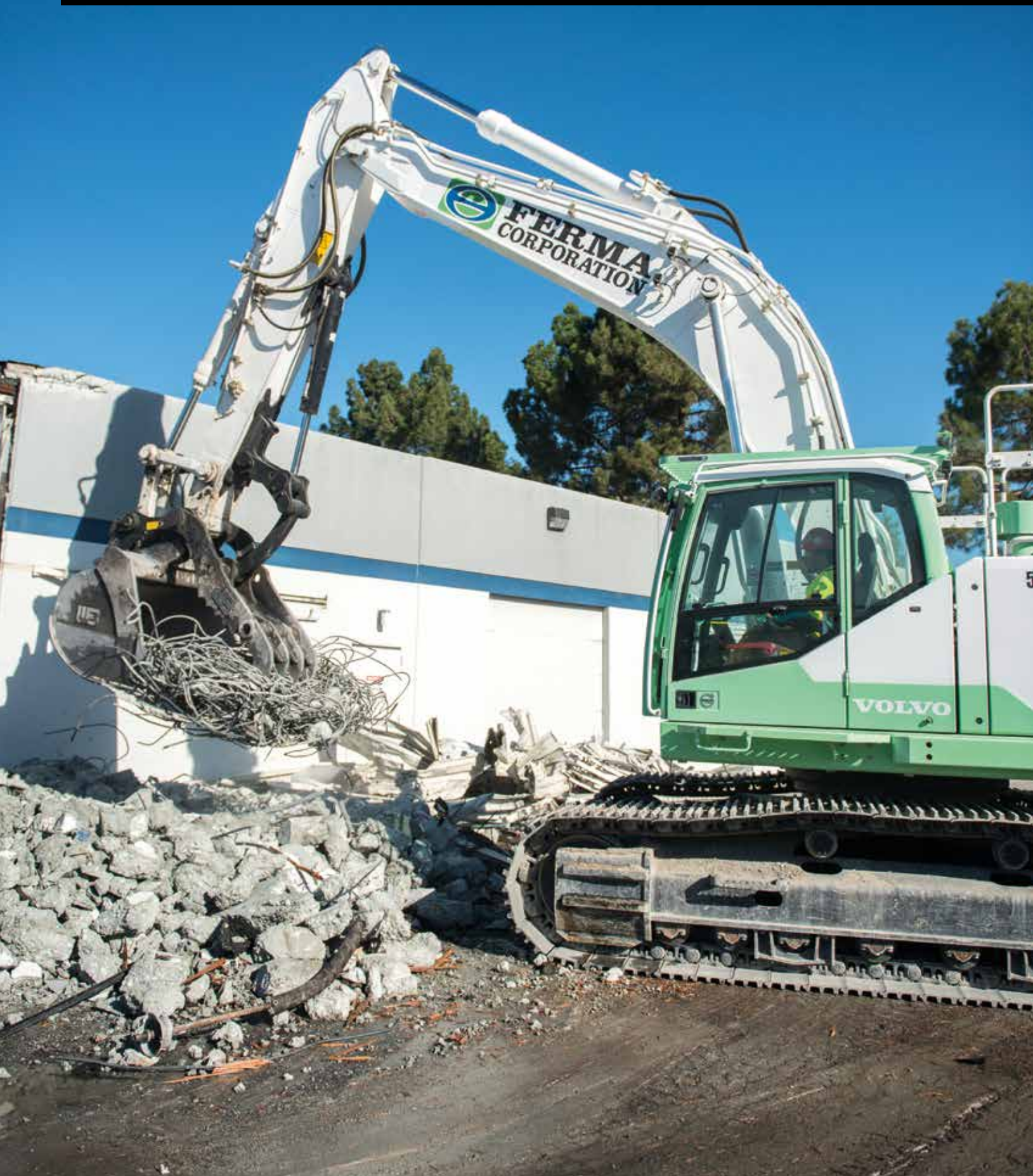
Spesialisasi FERMA adalah excavator jangkauan tinggi
