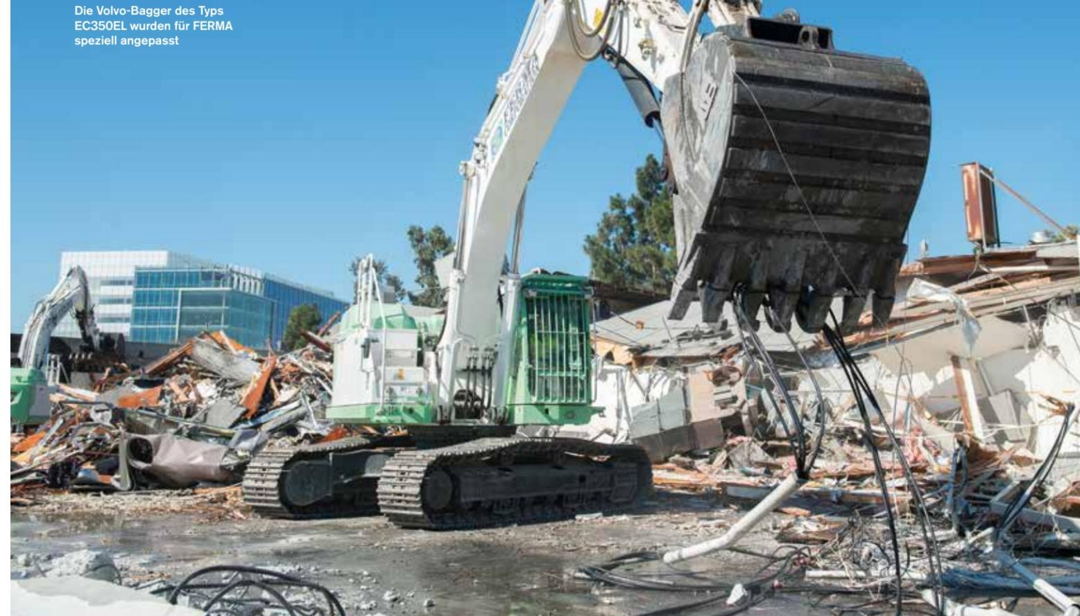
Die Volvo-Bagger des Typs EC350EL wurden für FERMA speziell angepasst
