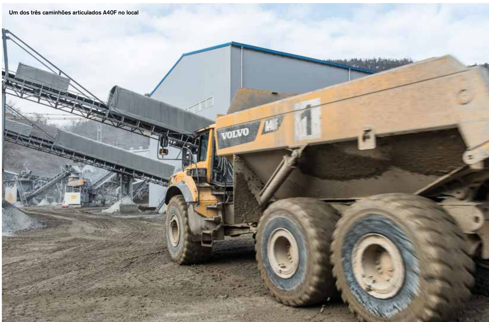
As escavadeiras carregam pedras nos caminhões
