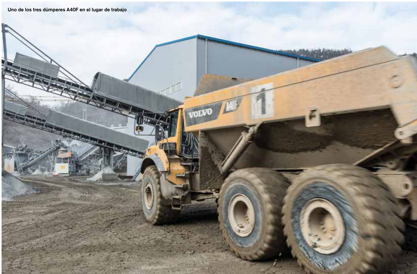
Excavadoras cargando piedras en los dúmperes
