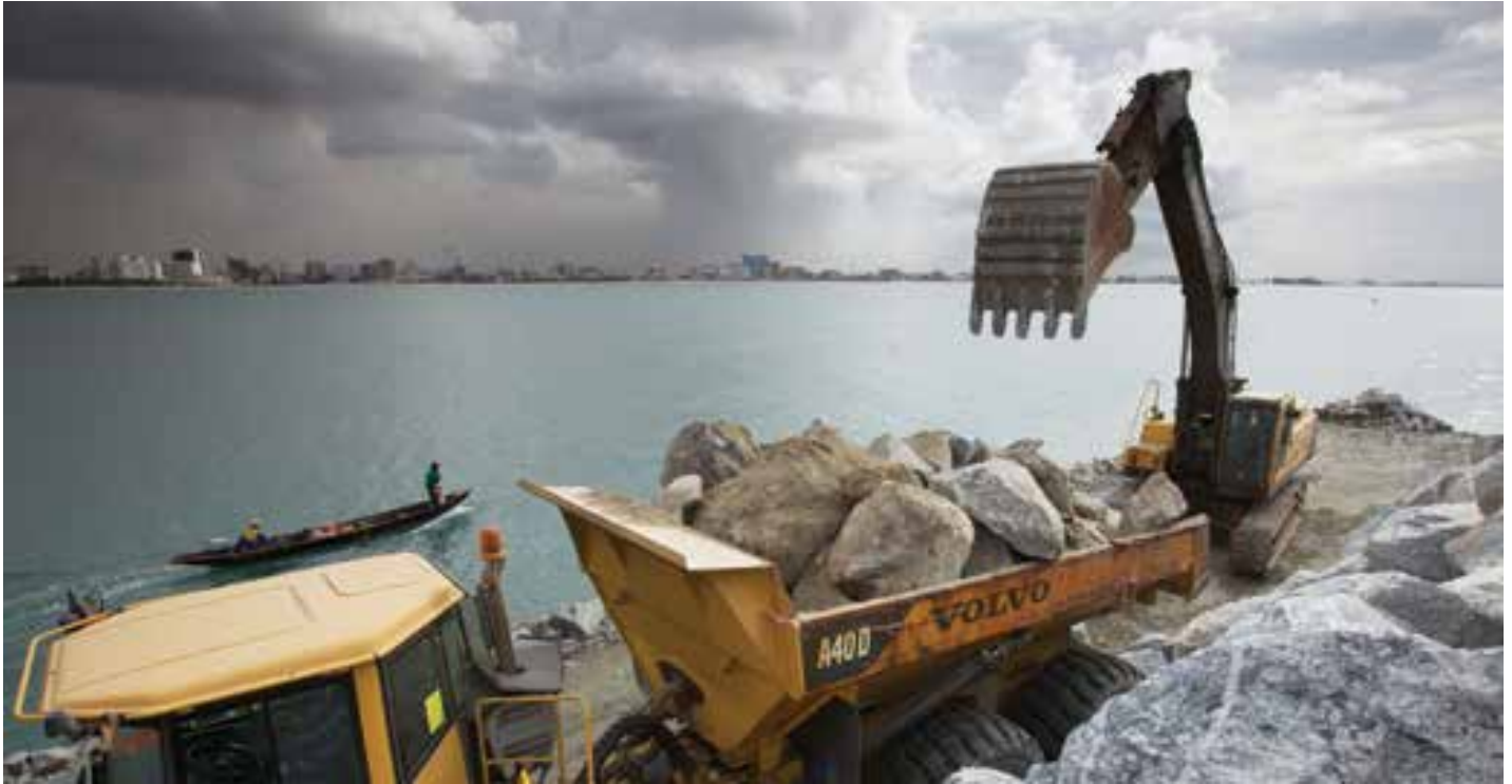
Die Volvo-Maschinen arbeiten auch unter sehr schwierigen Bedingungen und meistern diese hervorragend.
