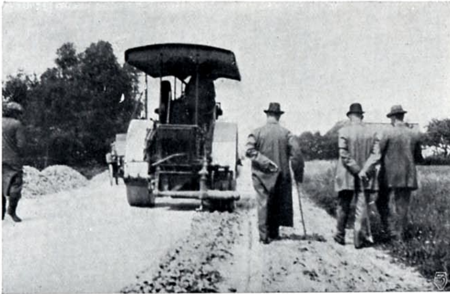
Vägrivaren i arbete.
