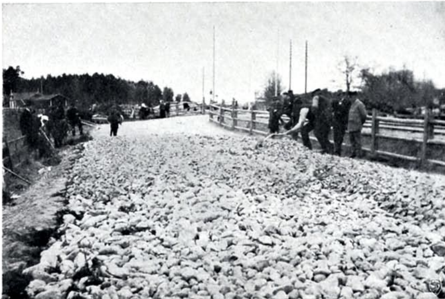
Grunden på en gammal väg förstärkes.
