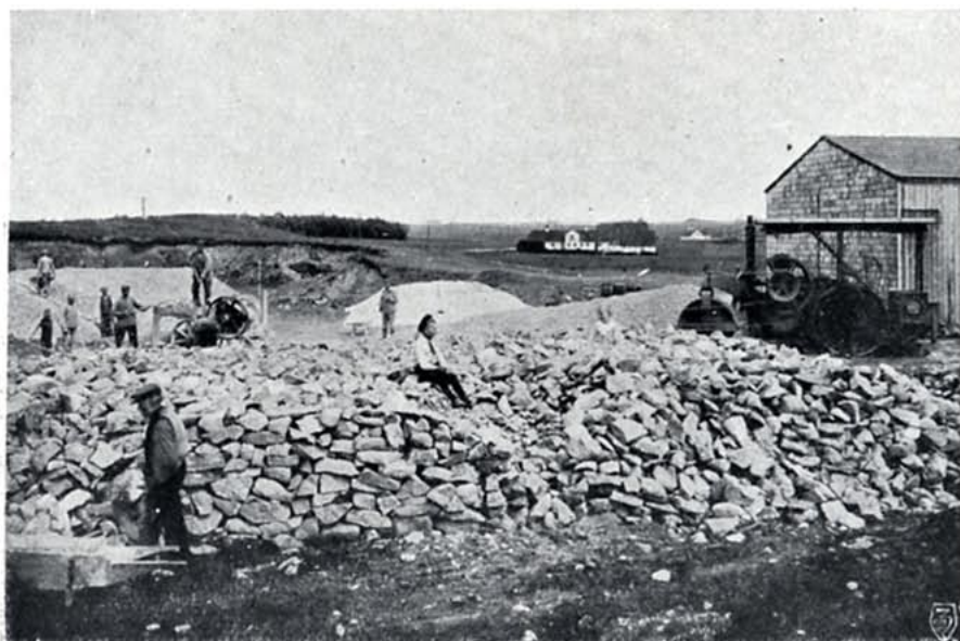
Motorvält arbetande i kombination med stenkross.
