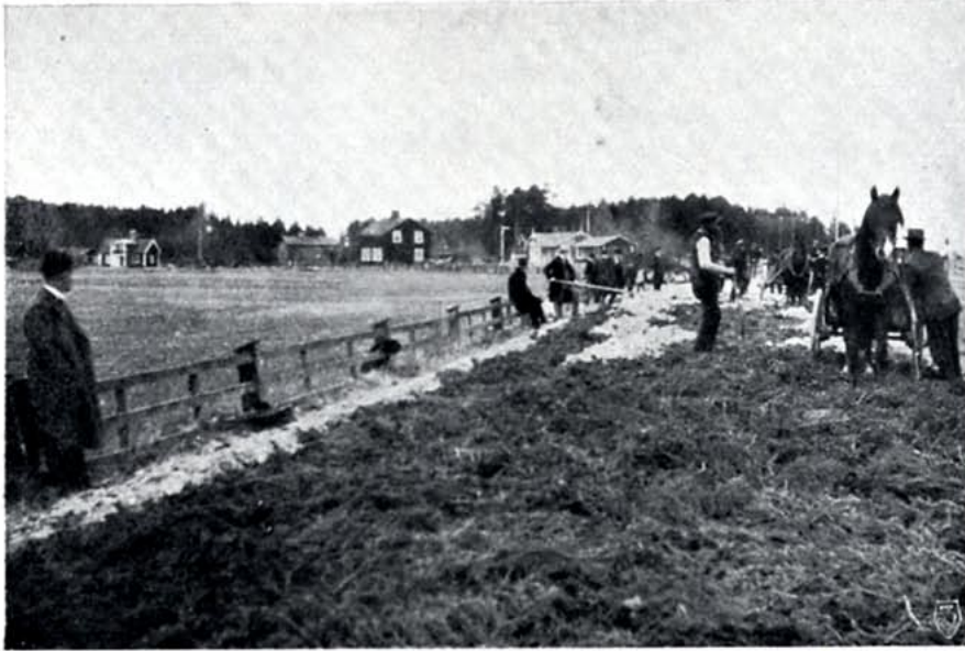
Isolering av vägbanan emot jäslera med granris i dubbla lag.
