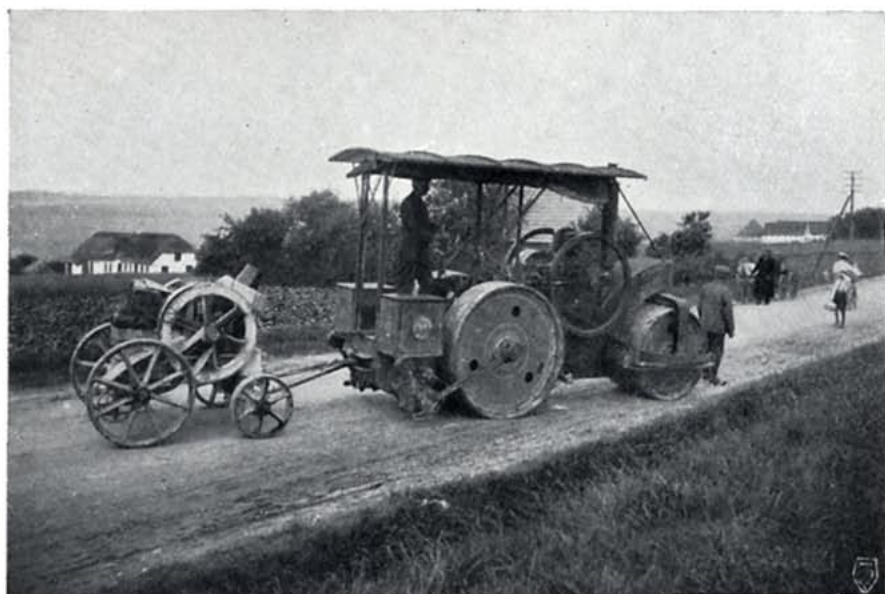
Motorvälten bogserar med lätthet stenkross och övriga redskap för vägunderhållningen. Stigningar t. o. m. 1 : 7½ tagas utan svårighet.
