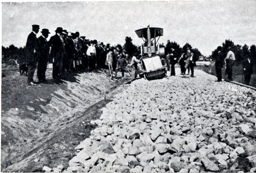
Motorvälden »sätter sig» på vädkanten, men arbetar sig åter upp. En ofarlig situation för en stabil vält med stora drivvalsar.
