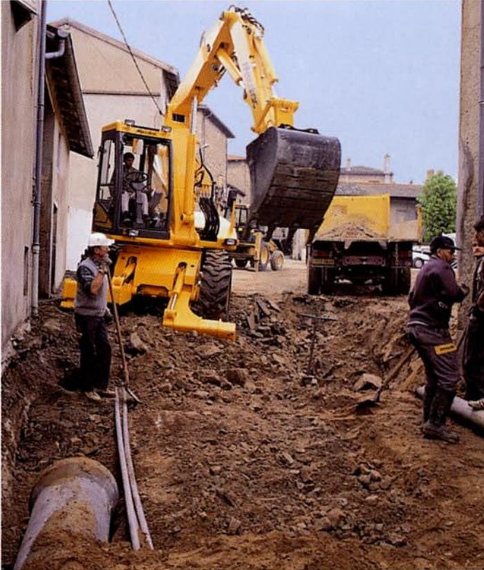
*“7.30 Uhr. Wir nehmen den Graben in Angriff. Die Baustelle ist eng und in der Höhe durch elektrische Leitungen begrenzt. Der Mecalac 14 MXT gräbt vorne und belädt direkt den LKW der hinter ihm steht. Das versetzte Arbeiten links und rechts entlang der Mauer bereitet keine Probleme. Die Arbeit in der Betriebsart “Bagger” ist einfach, weil die Pedale nicht benötigt werden.”*
