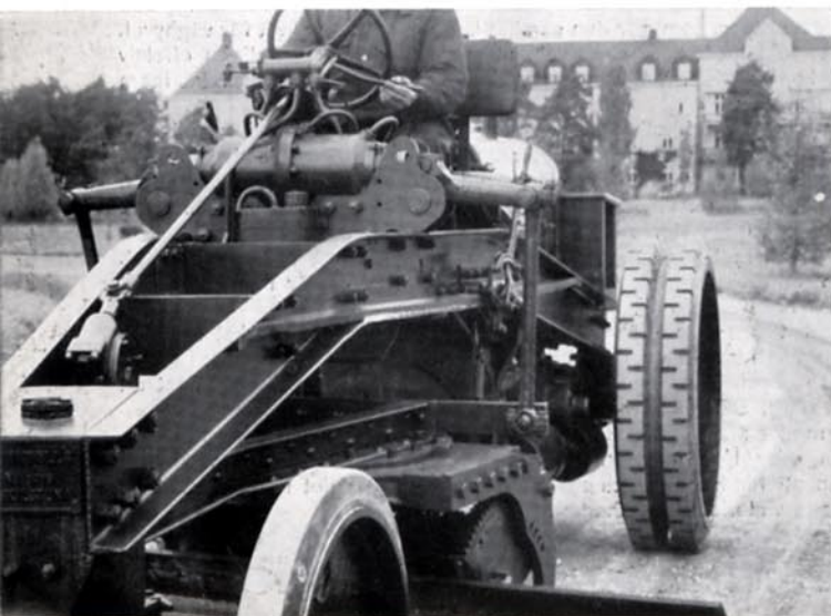
Förstärkningen på rambalkarna
