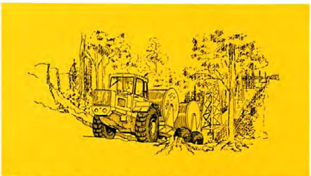
Tamburi per la posa parallela di due cavi.
