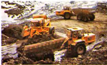
Construction d'un barrage de centrale hydro-électrique, en Autriche.
