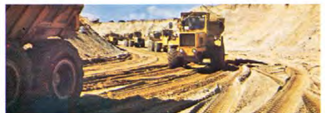
Construction d'une route, aux Pays-Bas.
