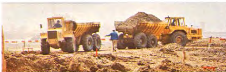
Construction d'un aéroport, en Suisse.
