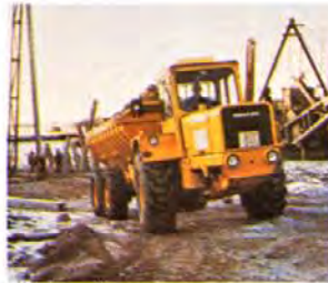
Construction d'un pont, en Suède.
