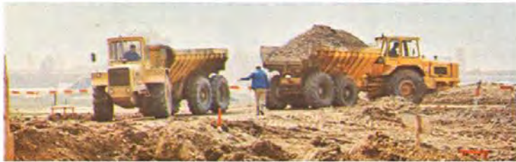
Opførelse af lufthavn, Schweiz
