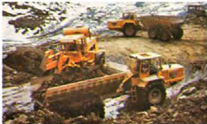
Anlæg af kraftværksdæmning, Østrig
