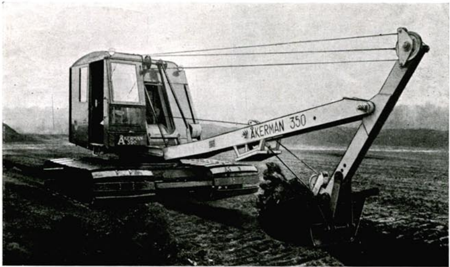
Dikning på torvmosse. Maskinen utförd med speciell under-vagn och breddade larvband för arbete på torvmossar och annan lös mark.
