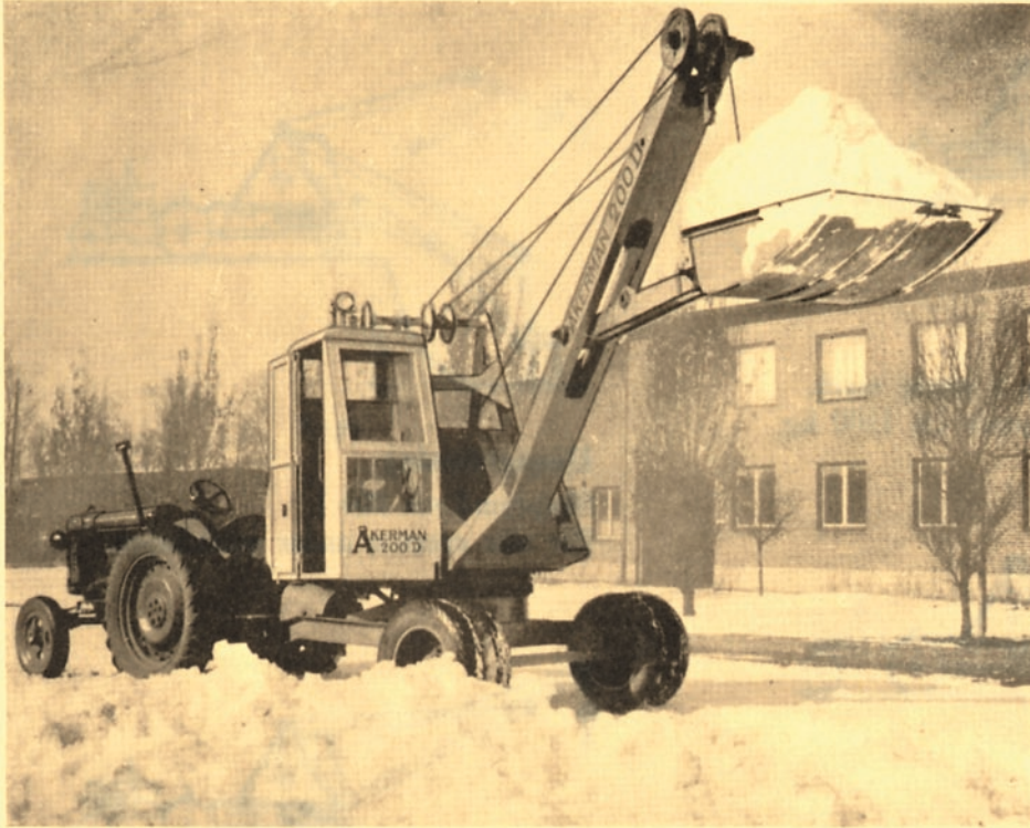
Fig. 4. Maskinen utrustad för snölastning och snöröjning.
