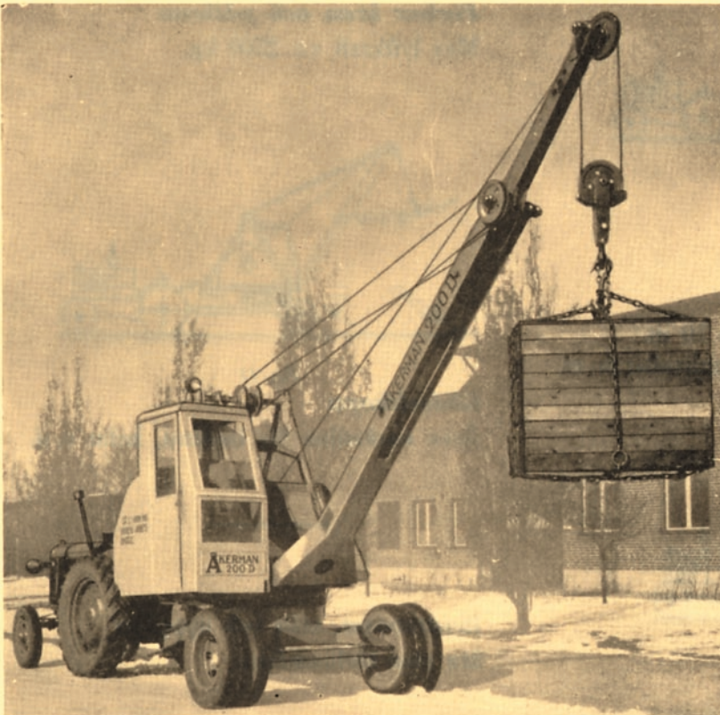
Fig. 5. Maskinen med kranutrustning. (Bommen förlängd med skafte.)
