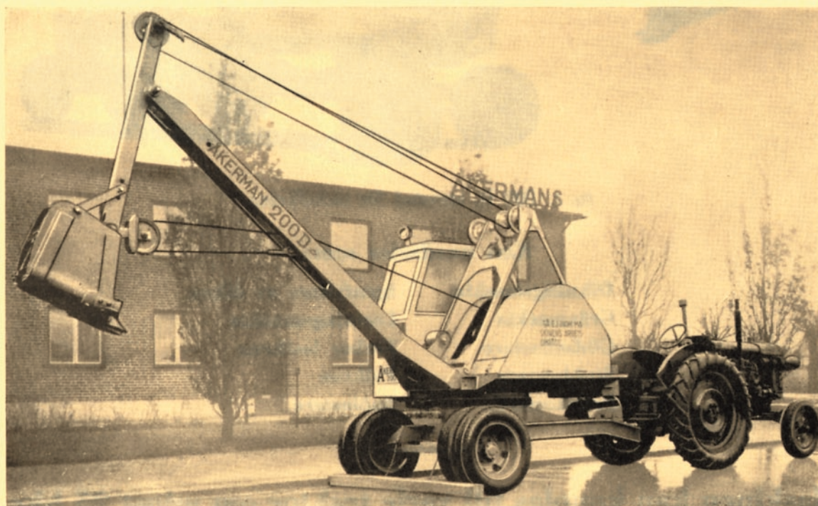
Fig. 3. Normalskopan monterad för djupgrävning.
