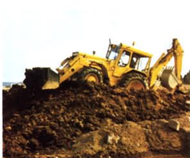
Bra dragkraft gör schaktnings- och planeringsarbetet effektivt
