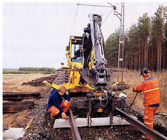
Byte av järnvägsslipers.
