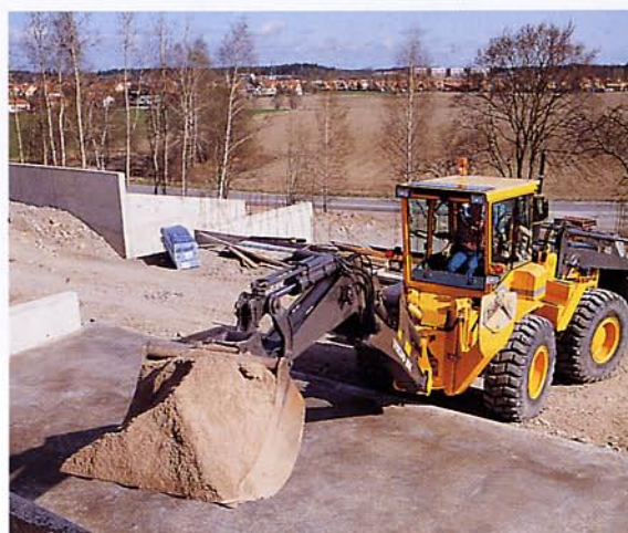
Materialhantering på byggarbetsplats.
