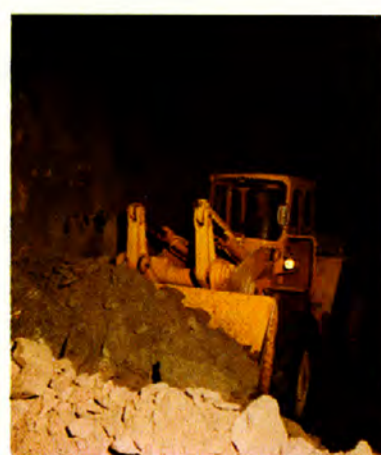
BM-VOLVO LM 1240 i tunnelarbete
