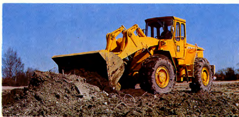
BM-VOLVO LM 1240 i jordschaktning
