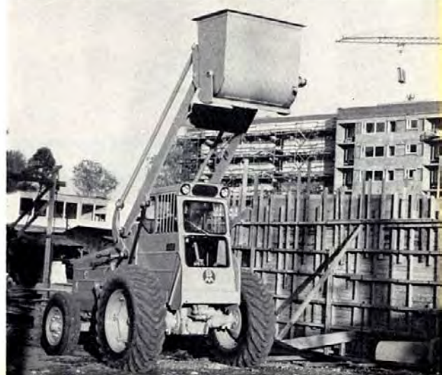
Manutention de béton, de mortier et d'autres produits en vrac à l'aide du réservoir à béton à vidage par le bas à commande hydraulique.
