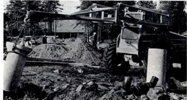
Pose de canalisations d'égoûts ainsi que chargement et déchargement de marchandises et de machines sur les chantiers de construction, par exemple, à l'aide de la flèche de grue prolongeable.
