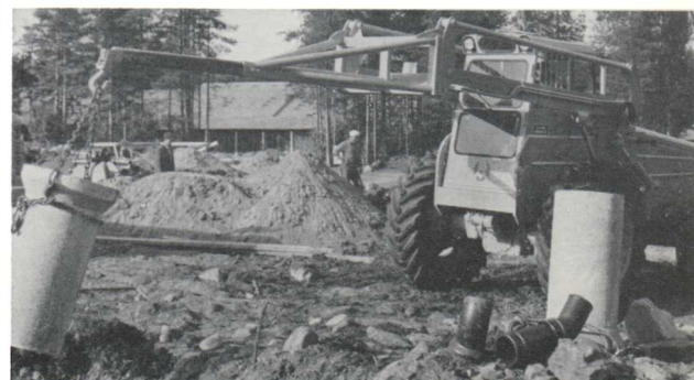
Läggning av avloppsrör samt lastning och lossning av gods och maskiner på t. ex. byggnadsplatser med förlängbar kranarm.
