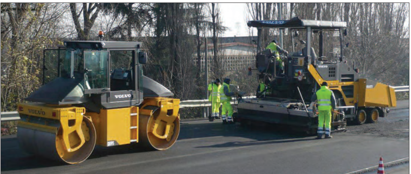
Figura 4 - Il treno di finitura costituito dalla vibrofinitrice Volvo ABG 6870 e dal rullo DD95 durante le prove effettuate in Provincia di Piacenza
