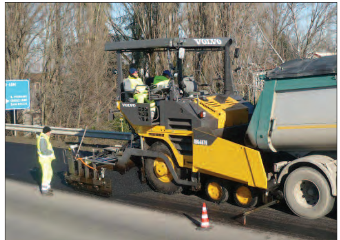
Figura 5 - Il carico di asfalto nella tramoggia
