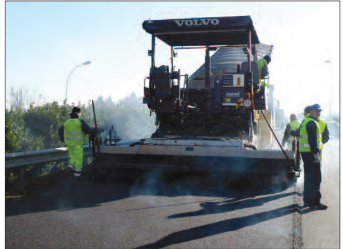
Figura 11 - La vibrofinitrice Volvo ABG 6870 in fase di stesa
