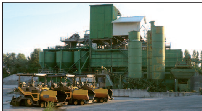
Figura 6 - L'impianto di produzione dei conglomerati bituminosi
