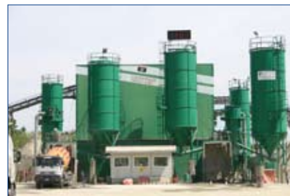
■ L'impianto per la produzione di calcestruzzo preconfezionato
