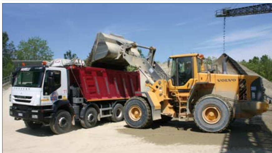
■ La pala gommata Volvo L180 F durante le operazioni di carico degli inerti
