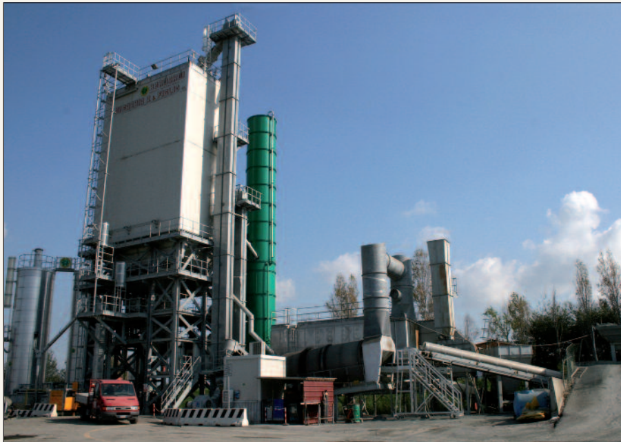
Figura 3 - L'impianto Bernardi tipo Met con produzione da 200 t/h
