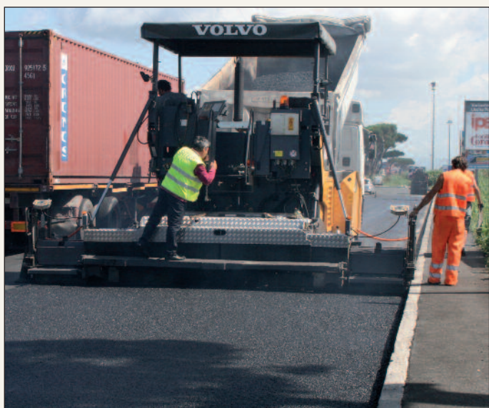
Figura 8 - La vibrofinitrice cingolata Volvo ABG 7820 con banco VDT- v 78 etc - 2,50 - 5,00 / 6,50
