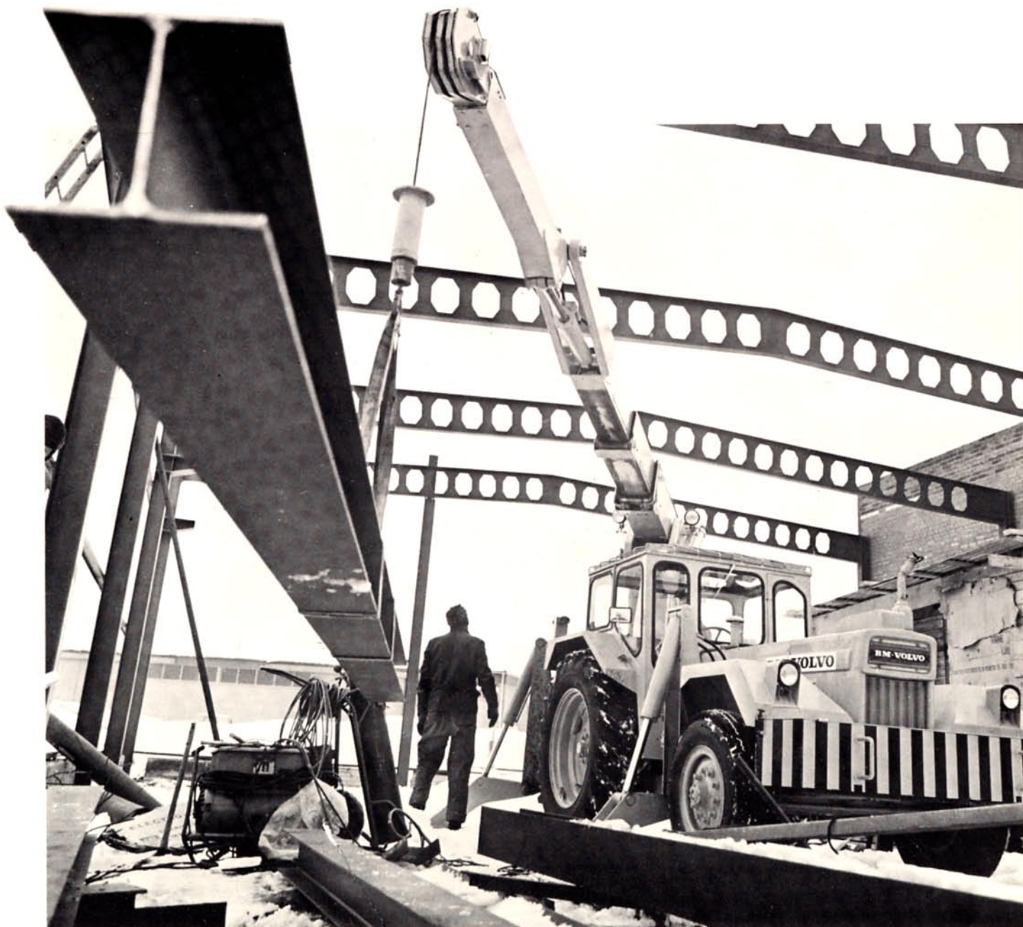
MK 691 kommer till sin rätt på trånga byggplatser. Maskinen kommer snabbt i arbetsposition och kranen arbetar följsamt och exakt med tung last. Räckvidd 11 m, Lyfthöjd 14 m.
