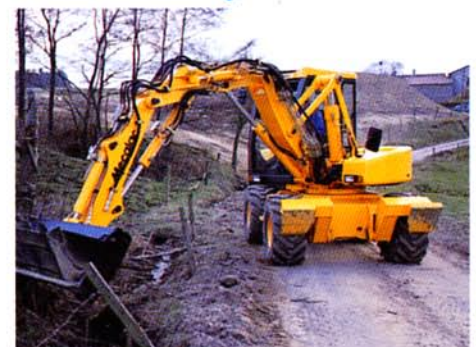
Arbeiten über ein Hindernis hinweg mit einer 4x1-Schaufel
