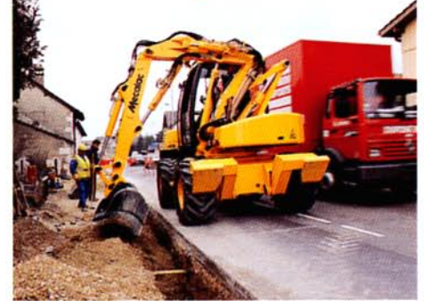
Verfüllung über einen Graben hinweg
