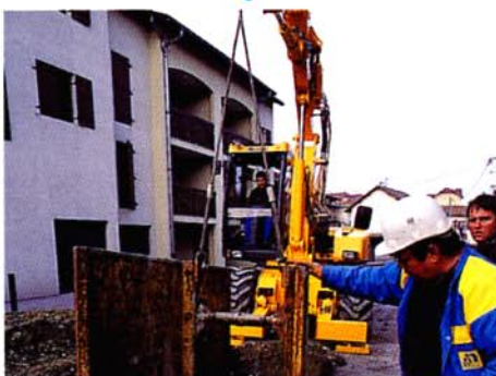
Umsetzen eines Grabenverbau, vorne...
