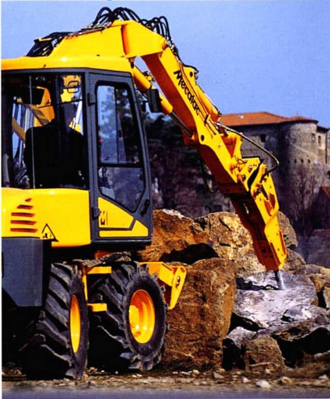
Arbeiten mit Hydraulikhammer
