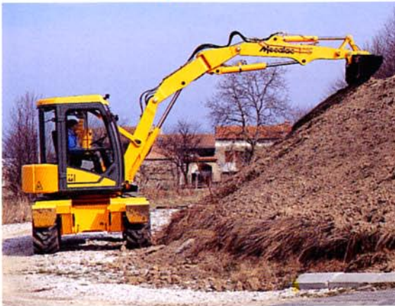
Anlegen einer 6 Meter-Böschung bis in Radnähe ohne Verkehrsbehinderung
