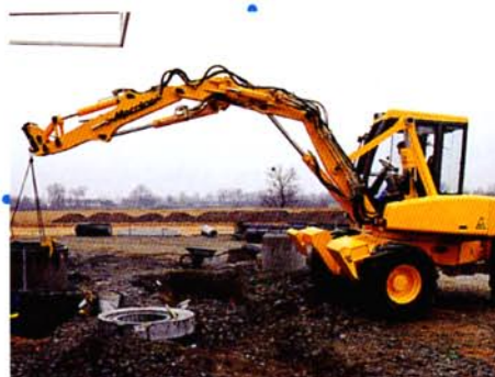
Vielseitigkeit auf Baustellen...
