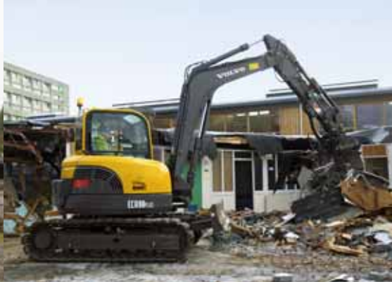
• Volvo bietet vollständige Lösungen für Abbruchprojekte.
