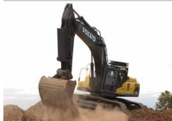
• Stabilità per compattazione di macerie da scavo.
