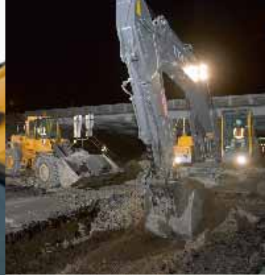
• Prestanda för återställning av arbetsplatsen.
