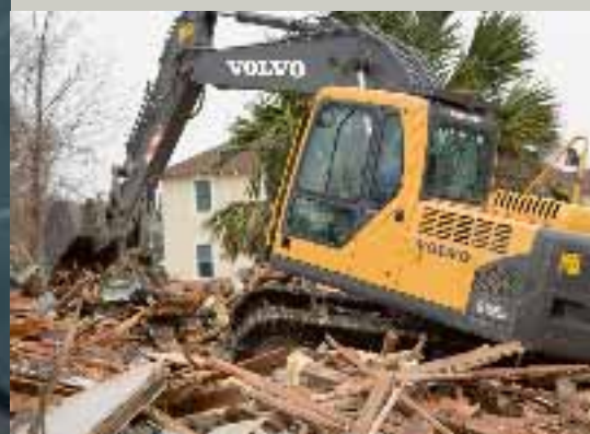
• Estabilidad para compactar y excavar escombros.
