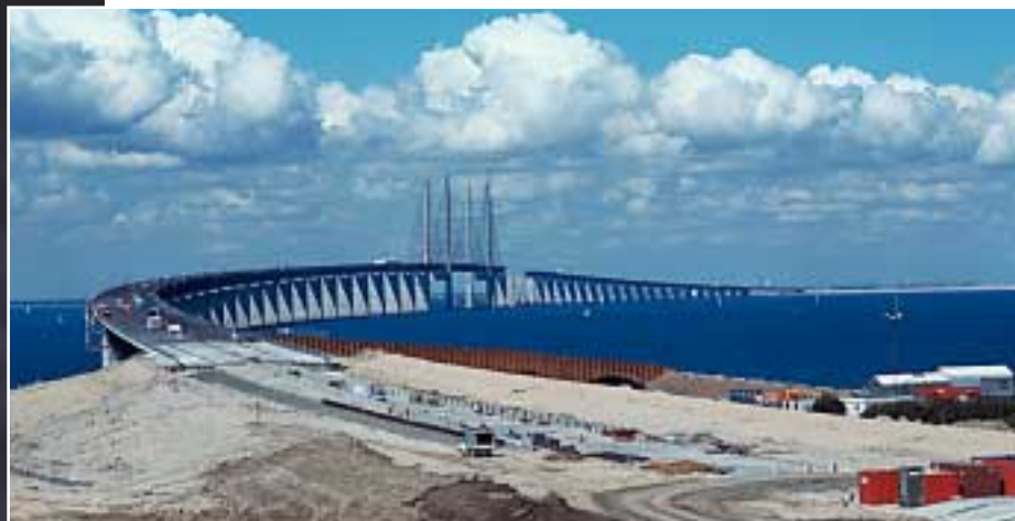
Große Erdbewegungsmaßnahmen, kurze Projektzeiten – hier zeigen Volvo A35D und A40D ihre Stärken.
