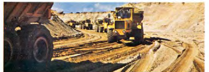
Construcción de autopista
