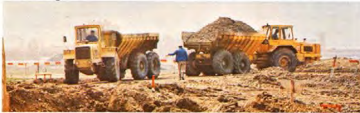
Construcción de un campo de aviación
