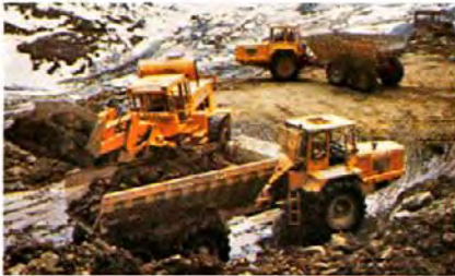
Construcción de una represa hidroeléctrica
