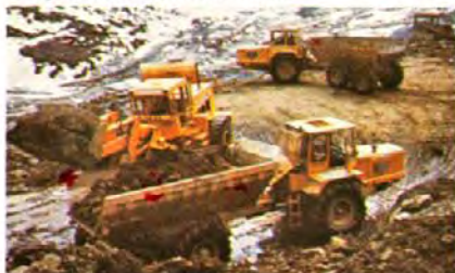
Aanleg van een stuwdam, Oostenrijk.
