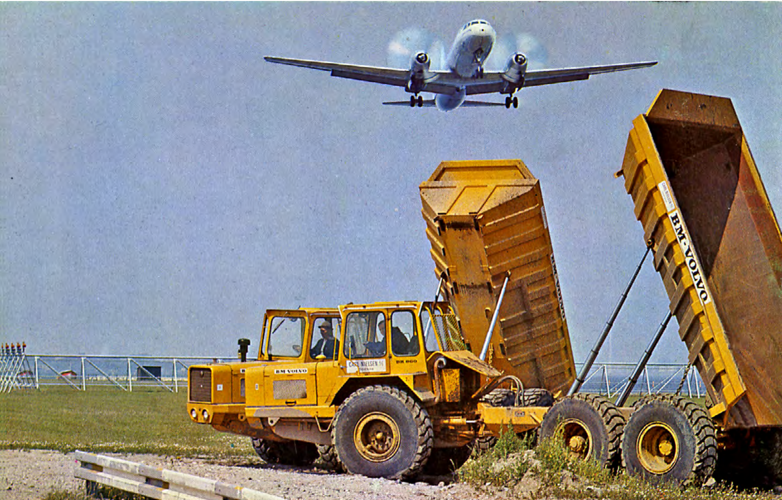
BM-Volvo DR 860-dumprar i arbete vid Kastrup flygfält, Köpenhamn
