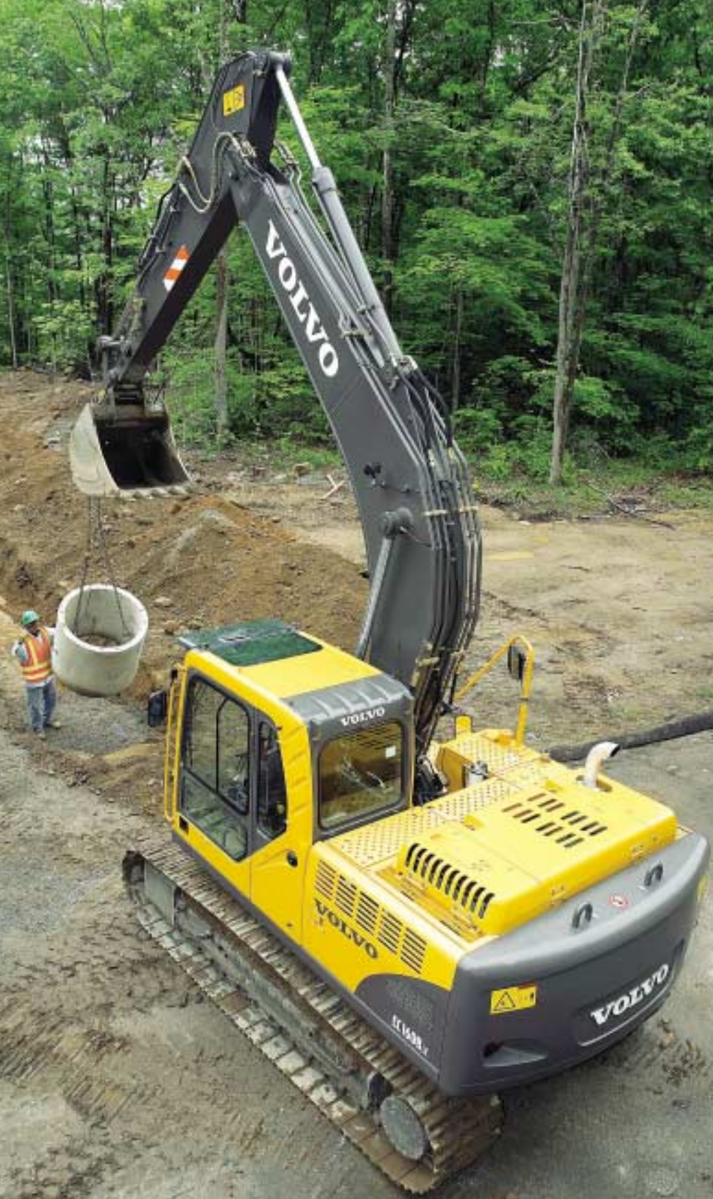
Manövrering: hydraulik som möjliggör precisionsplacering.
