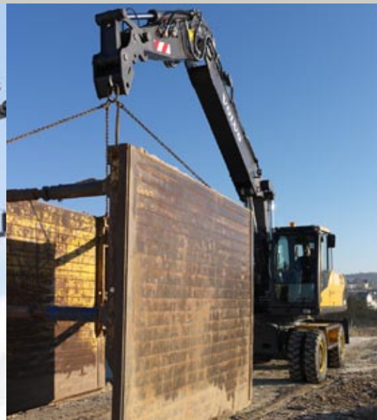
• Capacità di sollevamento e trasporto che compete con quella di un cingolato di 24 tonnellate.
