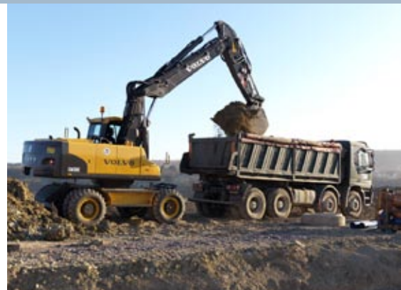
• Testati e collaudati sui cantieri di tutto il mondo.
