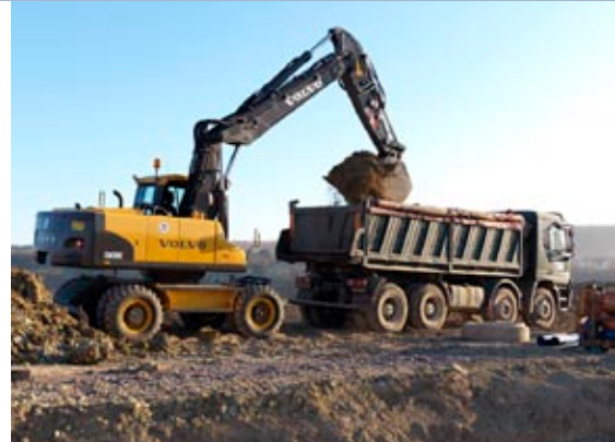
• Éprouvées sur d'innombrables chantiers.
