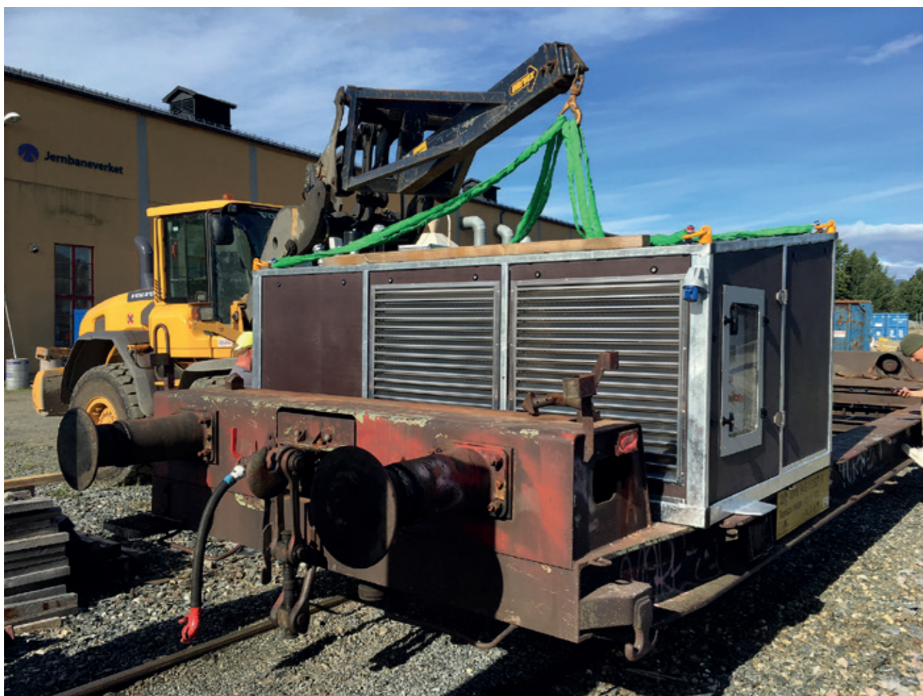
▲ Det første af tre spuleanlæg er ved at blive monteret på en jernbanevogn i Norge.
